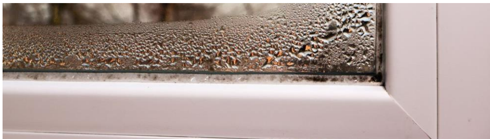
Bildung von Kondenswasser am Fenster im Winter
